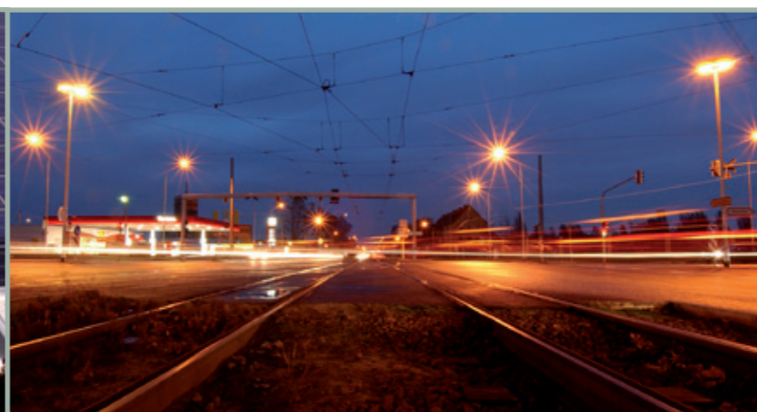
Beleuchtung B 91, Halle (Saale)
